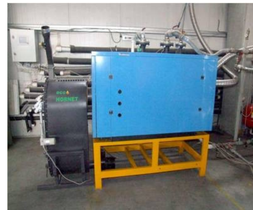
Arzator tip injector ecoHORNET 200kw montat pe cazan pe gaze Buderus Eficienta cazan, - cu gaze 78% / 145kw - cu peleti 95% / 200kw
